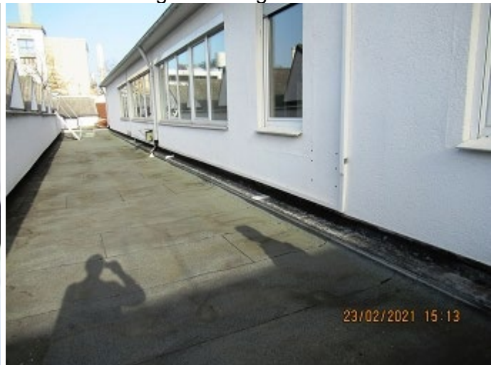
Die begehbare Terrasse kann genutzt werden.
