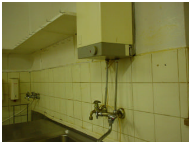
Küche Spülbereich Wandfliesen Fettfilm Grundreinigung / Kalkentfernung usw.
