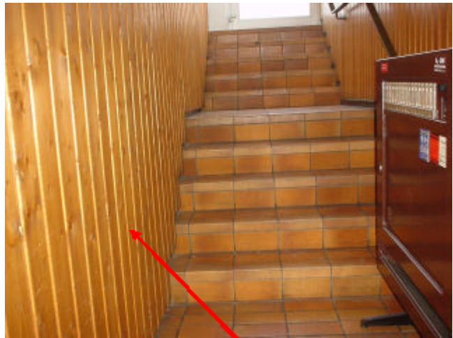
Eingangstreppe Holz wand Klinker 8,65m 2
